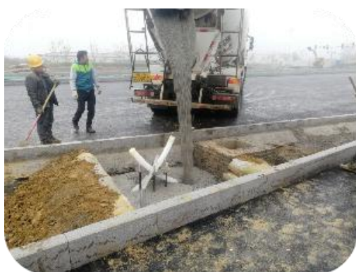
图 122 混凝土浇筑
