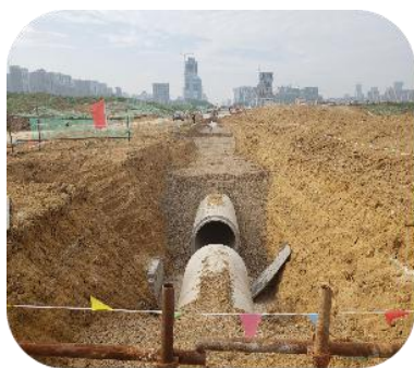
图 88 管顶碎石回填
