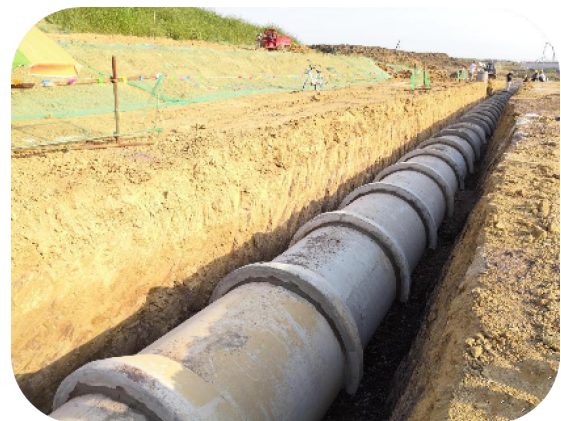
图 87 管道安装成型
