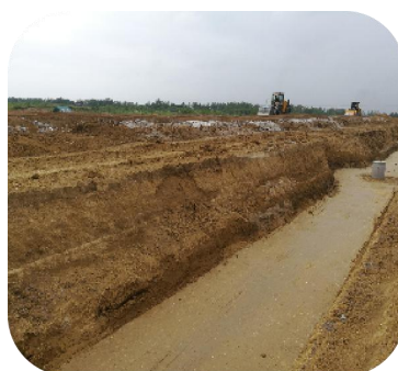
图 90 管道 50 灰土回填
