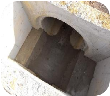
图 97 流水槽砌筑
