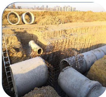
图 92 现浇钢筋砼检查井
