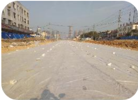
图 18 薄膜覆盖养生
