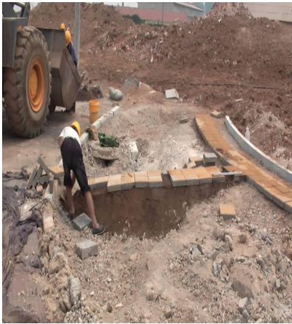
图 214 无基层施工
