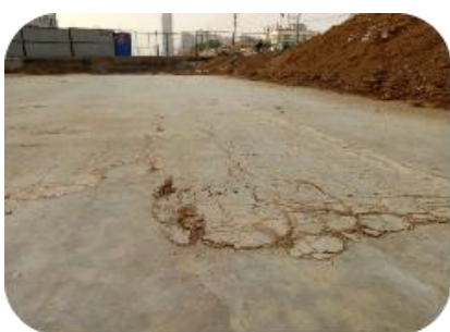
图 29 推挤分层
