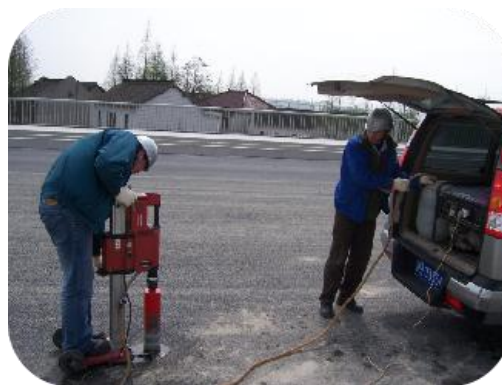
图 67 取芯试验
