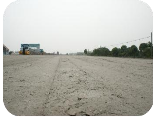
图 47 水稳表面弹簧、含水量大
