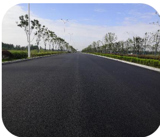
图 72 SMA 沥青终压后现场照片
