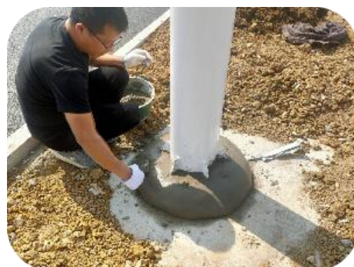
图 127 螺栓包封
