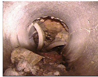
图 106 管道变形
