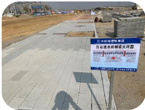
图 206 试验段铺设
