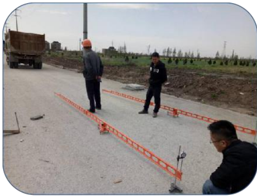
图 54 基层顶弯沉检测
