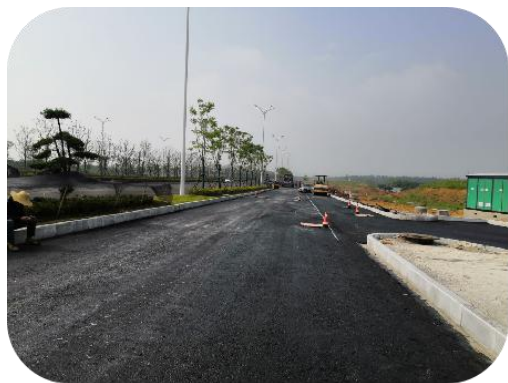
图 235 粘层油同步撒布
