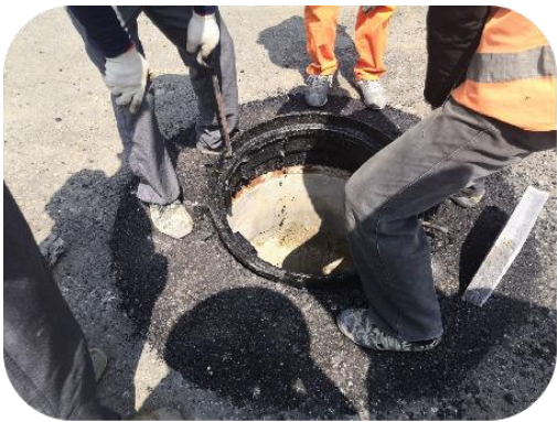
图 233 限位井圈拔出
