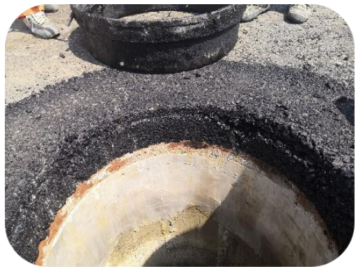
图 234 限位井圈拔出后效果
