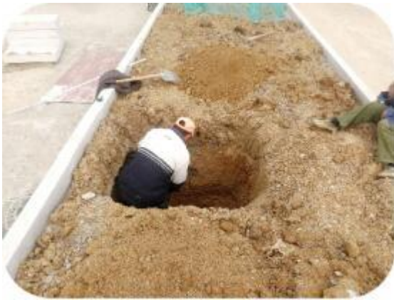
图 147 基础开挖
