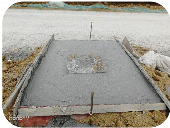
图 148 混凝土浇筑
