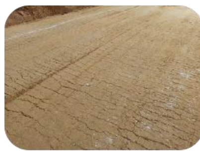
图 28 龟裂开裂
