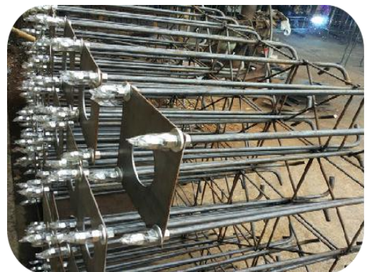
图 120 地脚螺栓验收
