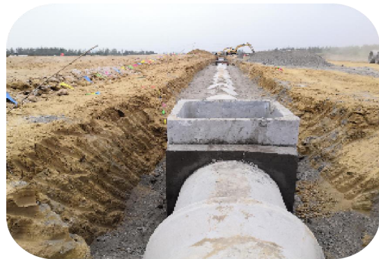
图 100 管道回填前照片
