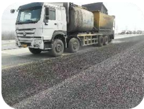
图 56 封层施工
