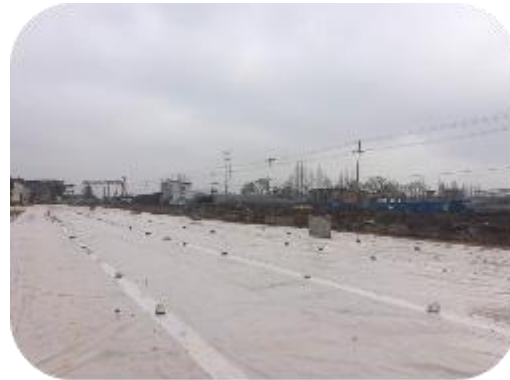
图 19 薄膜覆盖养生
