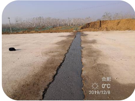
图 117 混凝土浇筑
