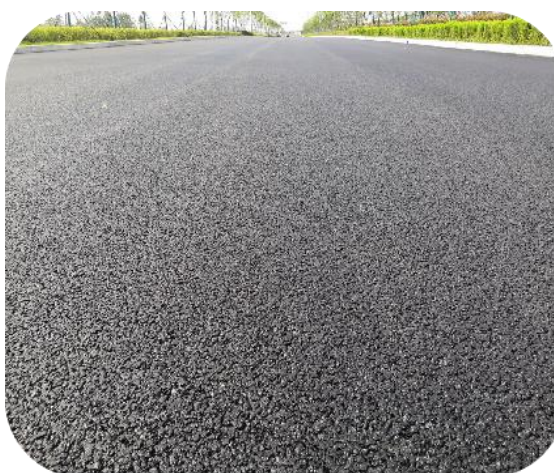
图 73 SMA 沥青终压后表面
