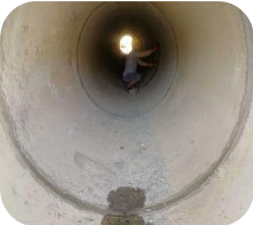
图 98 管道内壁检查
