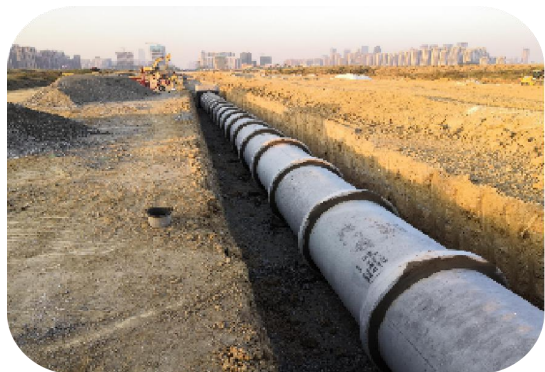
图 101 管道安装后效果
