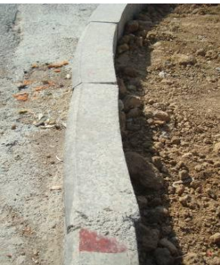
图 194 圆弧路缘石使用不当
