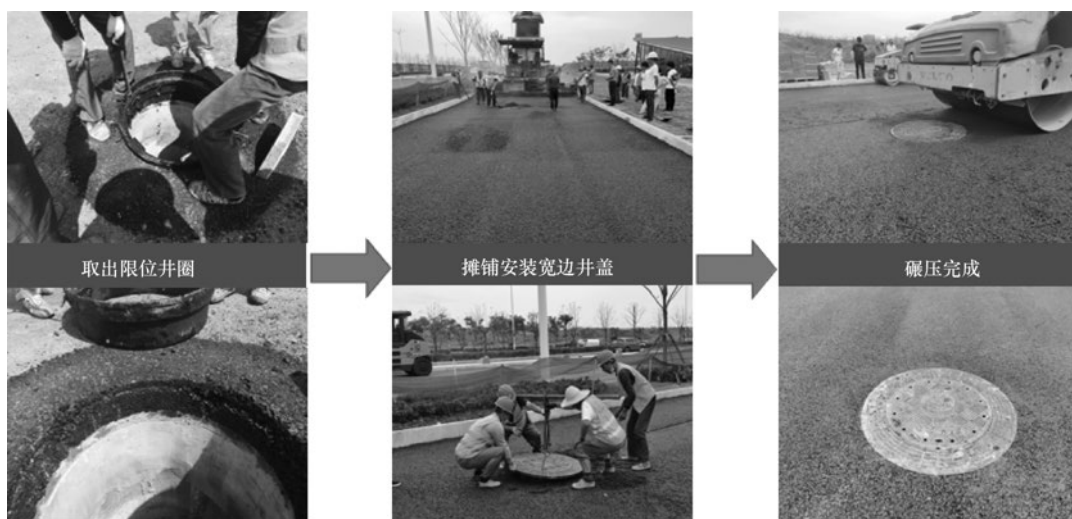
图 10.3.2-1 施工过程演示（二）
