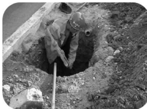
图 7.2.2-2 基础开挖
