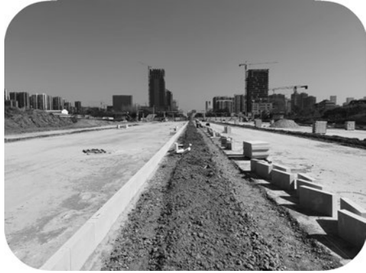
图 10.1.2-5 安装线型
