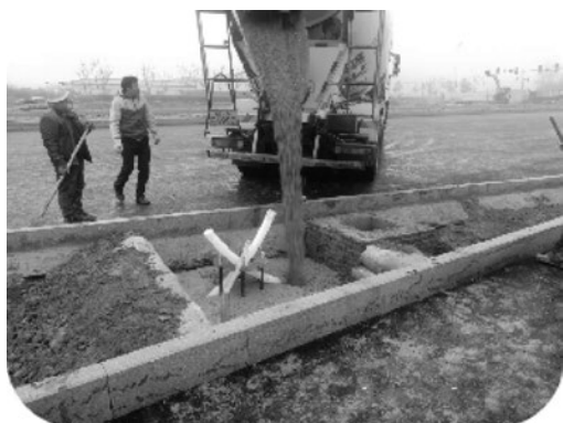
图 7.2.4-3 混凝土浇筑
