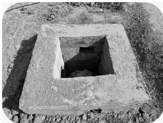
图 7.2.3-2 接线井砌筑
