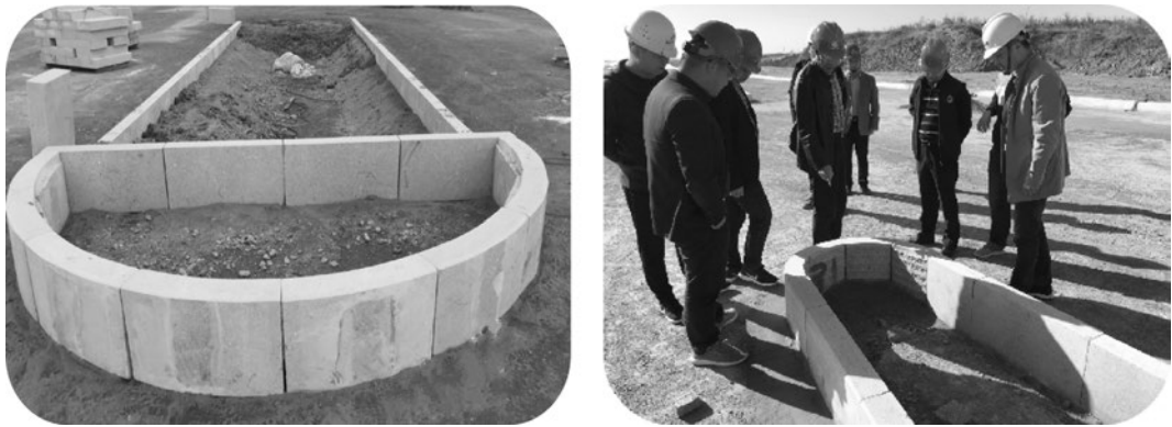
图 10.1.2-9 岛头圆弧段安装效果
