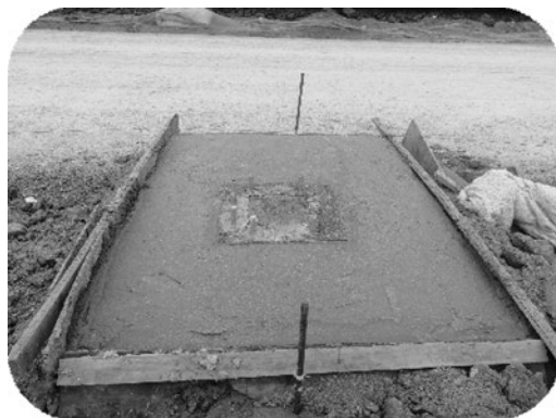
图 8.2.3-2 混凝土浇筑
