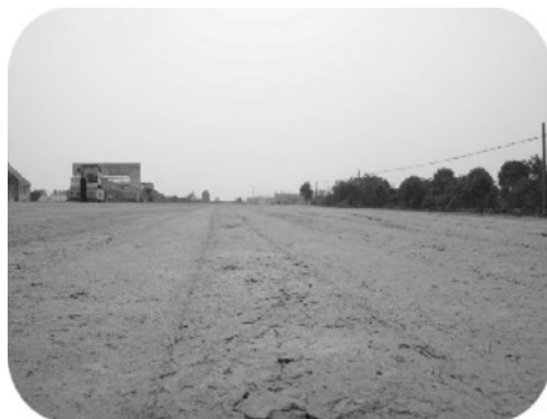
图 5.2.3-2 水稳表面弹簧、含水量大
