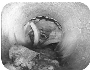
图 6.3.3-3 管道变形
