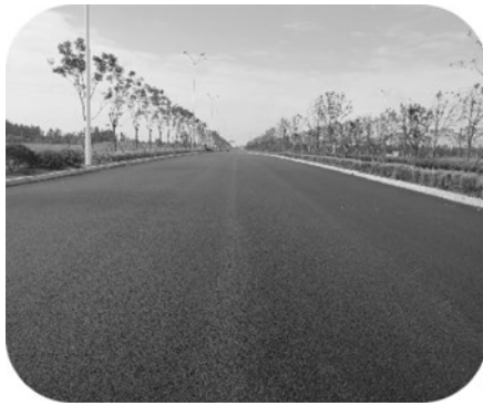
图 5.3.2-19 SMA 沥青终压后现场照片
