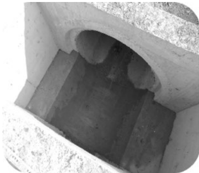
图 6.2.8-1 流水槽砌筑
