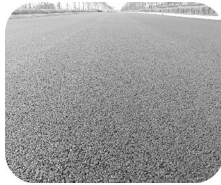
图 5.3.2-20 SMA 沥青终压后表面
