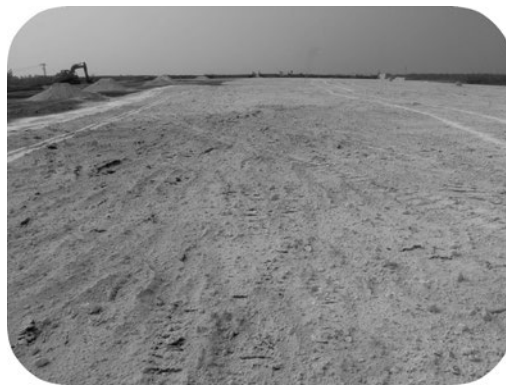
图 5.1.2-9 布石灰后效果图 (b)
