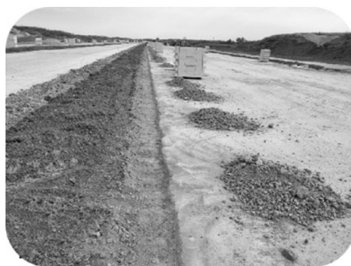
图 10.1.2-3 基槽开挖成型
