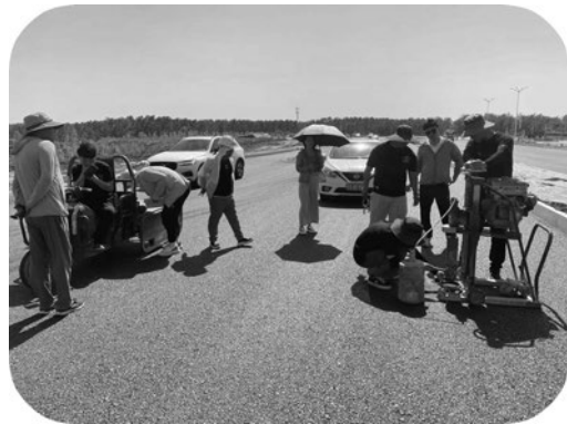
图 5.3.2-14 路面厚度检测
