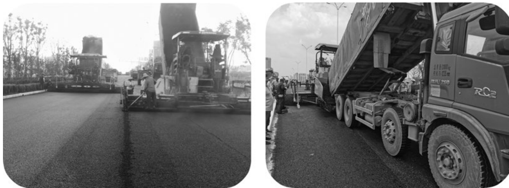
图 5.3.2-8 沥青混合料双机联铺
