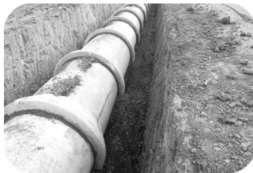
图 6.2.7-2 管道安装后效果
