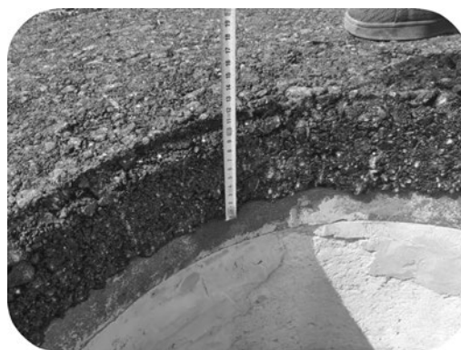
图 10.3.2-10 限位井圈拔出后效果
