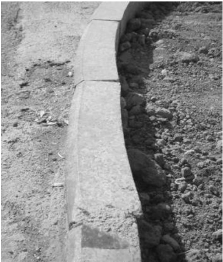
图 10.1.3-2 圆弧路缘石使用不当
