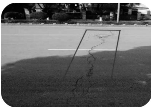
图 6.3.2-1 过路管道走向下沉
