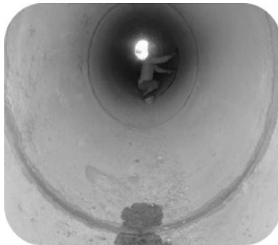
图 6.2.8-2 管道内壁检查
