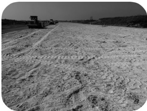
图 5.1.2-8 布石灰后效果图 (a)
