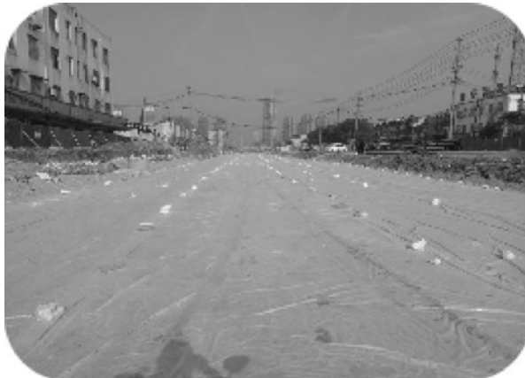
图 5.1.2-17 薄膜覆盖养生
