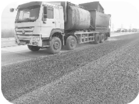
图 5.3.2-4 封层施工
