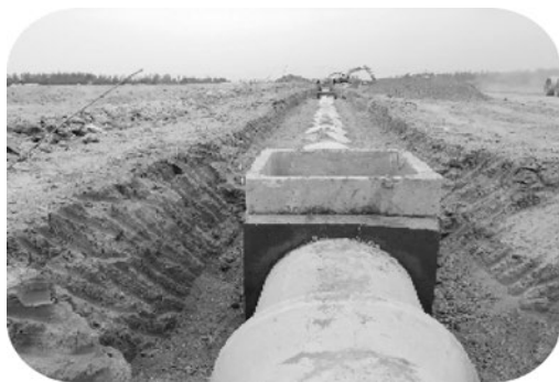
图 6.2.7-1 管道回填前照片
