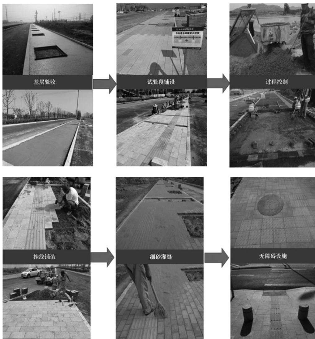
图 10.2.2-1 人行步道砖铺装施工过程演示
