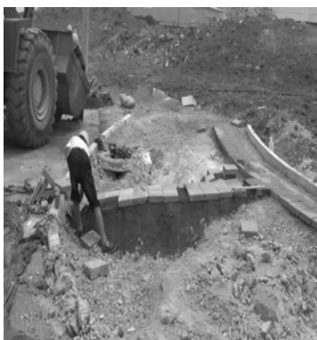
图 10.2.3-1 无基层施工
