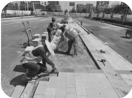
图 10.2.2-4 试验段铺设
