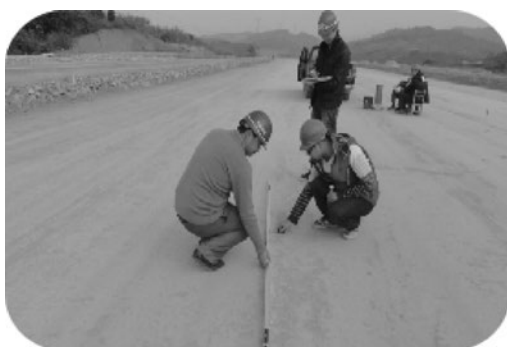
图 5.1.2-20 平整度检测
