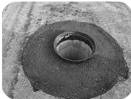
图 10.3.2-8 回填后效果
