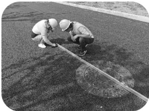
图 10.3.2-19 施工平整度检验
