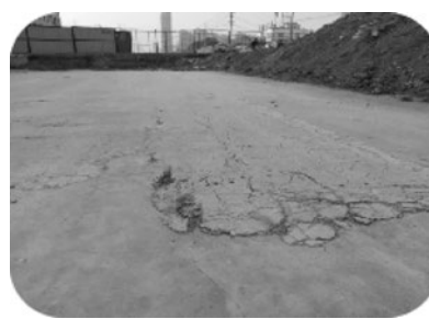
图 5.1.3-4 推挤分层
