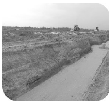
图 6.2.4-3 管顶 50cm 以上 石灰稳定土回填
