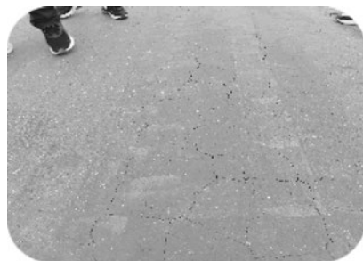
图 5.1.3-3 龟裂开裂
