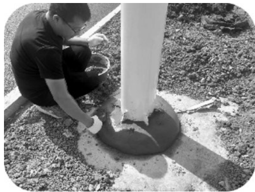
图 7.2.5-4 螺栓包封
