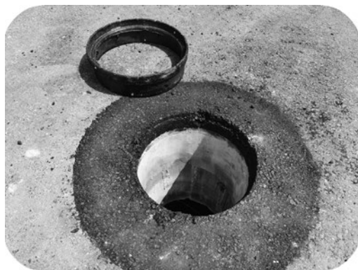
图 10.3.2-9 限位井圈拔出
