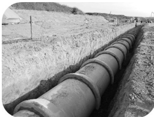
图 6.2.3-2 管道安装成型
