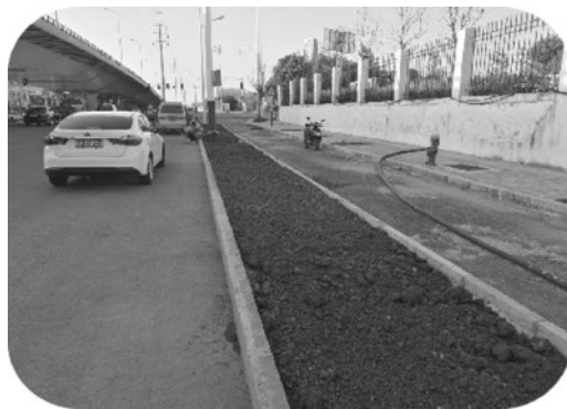
图 9.2.3-2 泥炭土回填后效果
