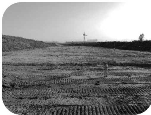
图 5.1.2-3 路基基底清表后现场
