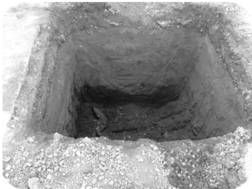
图 8.2.3-1 基础开挖
