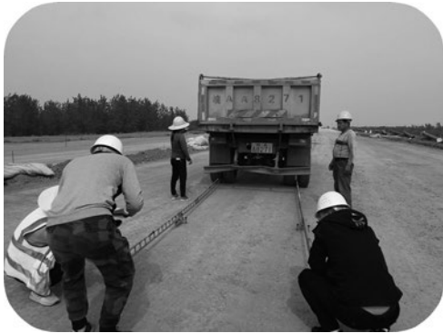
图 5.3.2-2 基层顶弯沉检测
