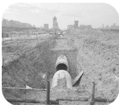
图 6.2.4-1 管道碎石回填
