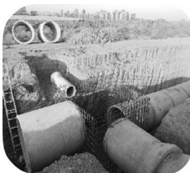
图 6.2.5-2 现浇钢筋混凝土检查井
